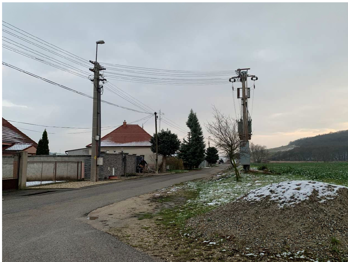
Obr. č. 19: Existujúca trafostanica
