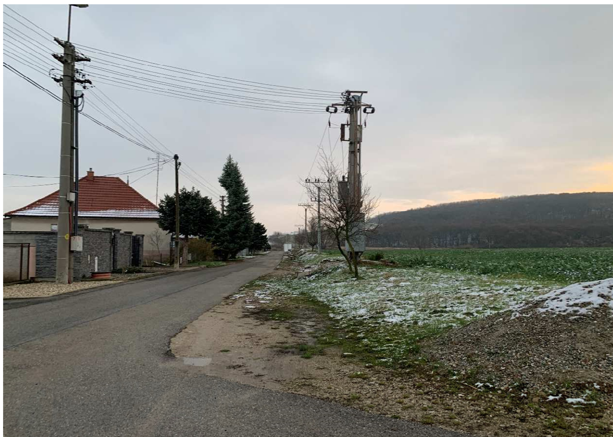
Obr. č. 15: Elektrické vedenia s trafostanicou
