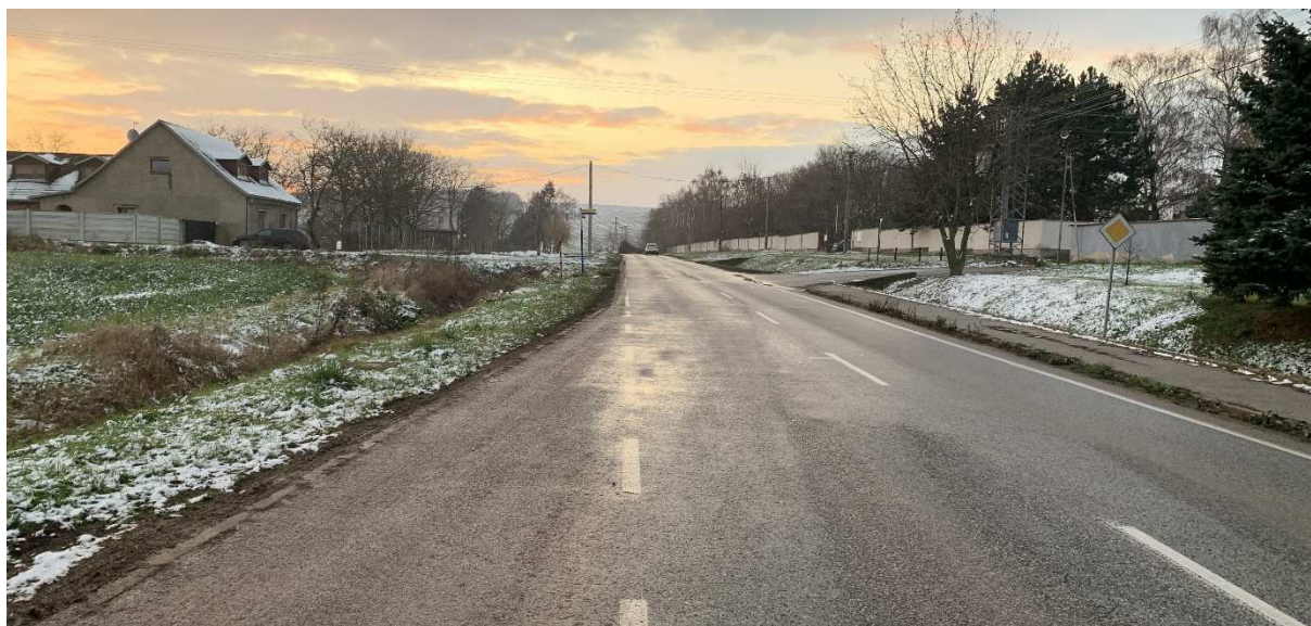
Obr. č. 5: cesta II.triedy Hlohovec – Sereď č. II/507 (C 9,5/70)
